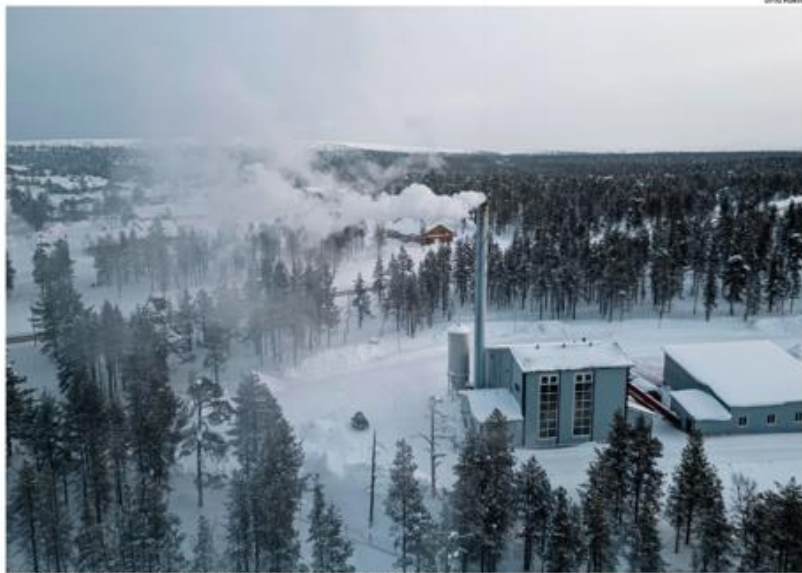
Inergia polttaa lämmöksi vuodessa 20000–25000 kintokiloa puubiomassaa, toimintajätettä kerton. Kuvassa Inerian kaukolämpölaite Saariselän matkakeskuksessa.
